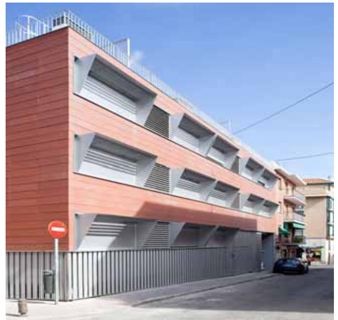
Vista general del edificio. Fachada sur. 2009
