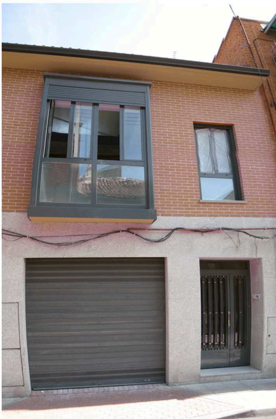
Edificio de obra nueva en la C/ Mar de Bering, 3. Madrid.
