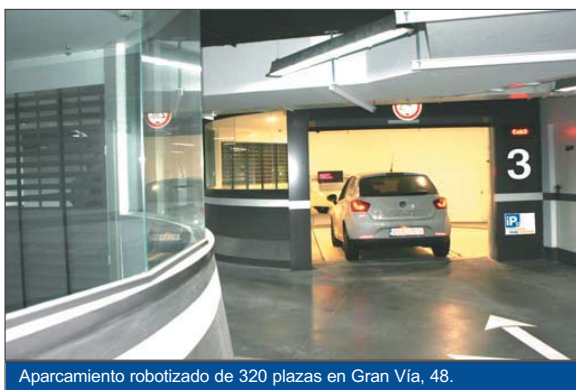
Aparcamiento robotizado de 320 plazas en Gran Vía, 48.
